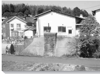
大袋鉄橋の橋脚
