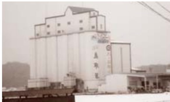
南部カントリーエレベーター
