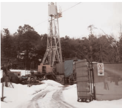
オートキャンプ場掘削現場
