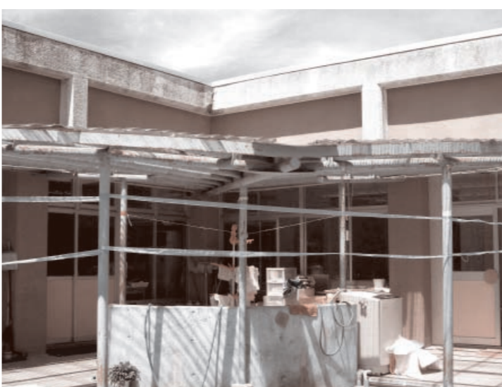
老朽化が進む、すみれ保育園
