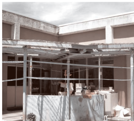
老朽化が進む、すみれ保育園
