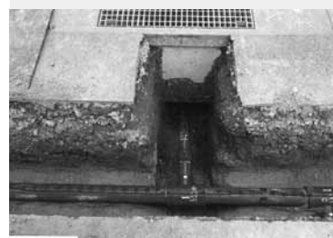
老朽管布設替工事
