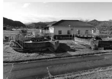
下水道処理施設
