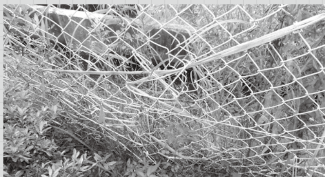
フェンスの破損
