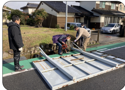
道路側に倒れた2区・3区の住宅案内看板、通行人等に被害が無くてなによりでした
