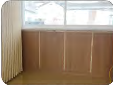
修繕された大集会室の壁
