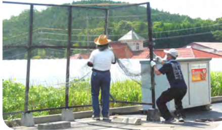
木製フェンスの撤去作業
