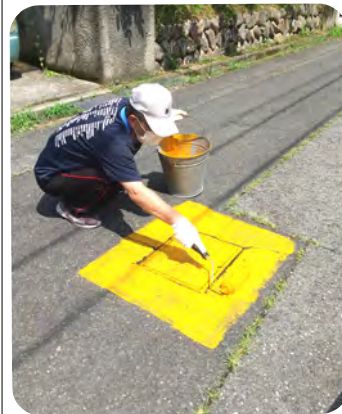
ホース格納箱の近くに黄色く塗装された消火栓があります。
