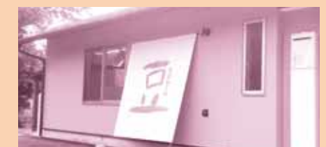
法勝寺温泉内、大豆加工施設設置
