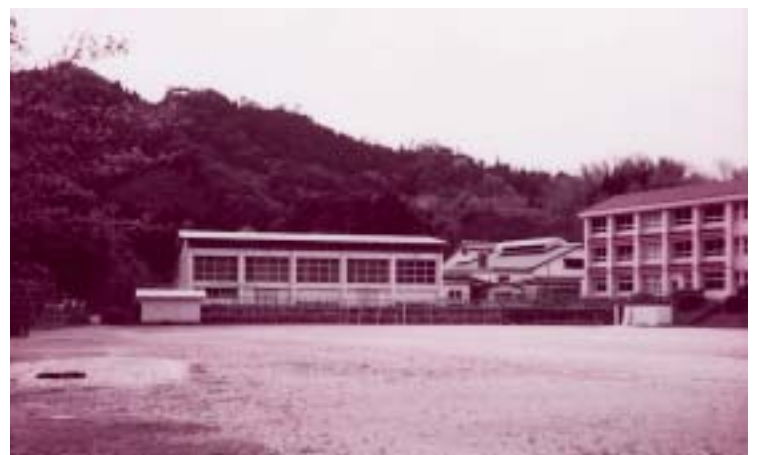
会見小学校体育館
