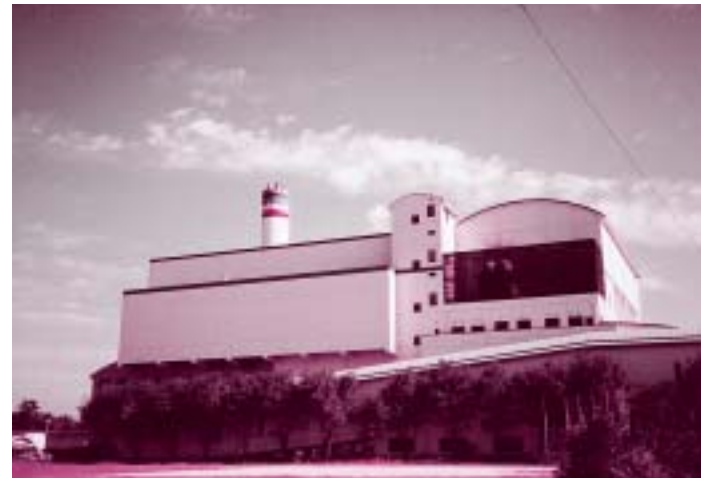
米子クリーンセンター
