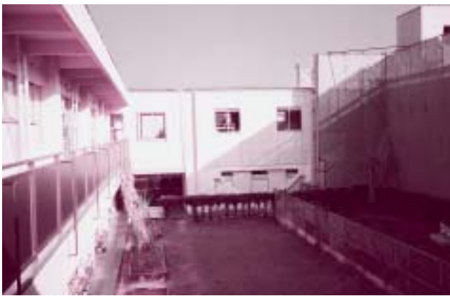
耐震工事中の白山小学校
