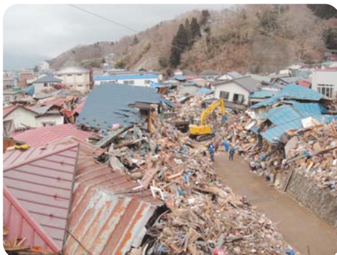
宮古市の被災状況
