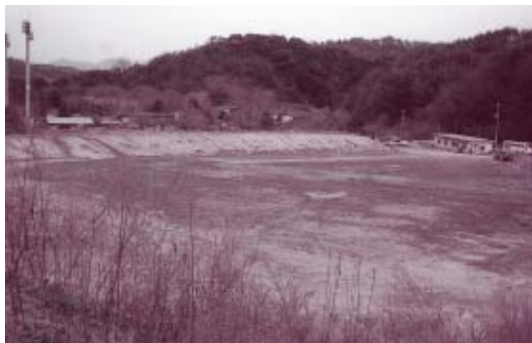
残土処分場予定地
