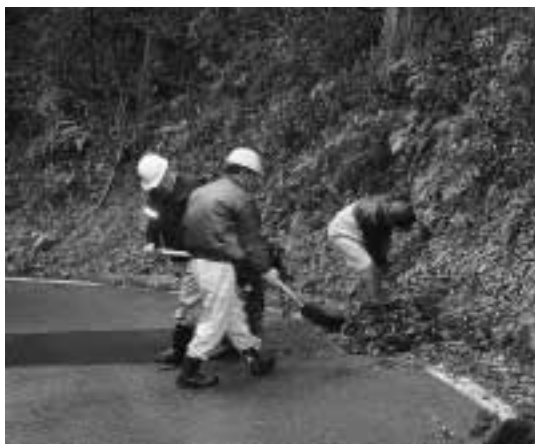
側溝のごみを取り除く
