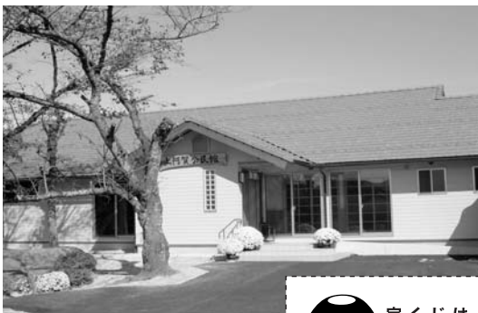
完成した上阿賀コミュニティセンター
