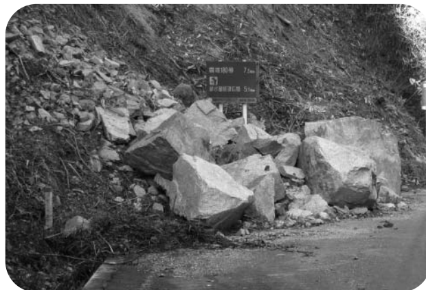
林道鎌倉山線災害現場
