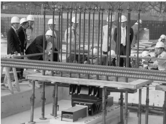
柱の下に設置される免震装置（直動転がり支承）見学の様子
