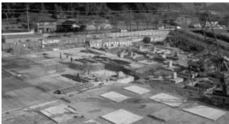
改築工事の様子（H16.10.29現在 / 基礎工事）
