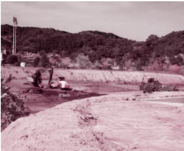
事業開始された残土処分場
