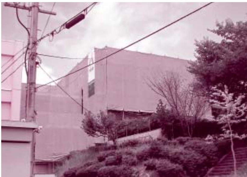
会見小後ろ校舎改修工事
