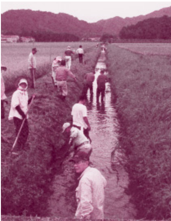
水路清掃作業
