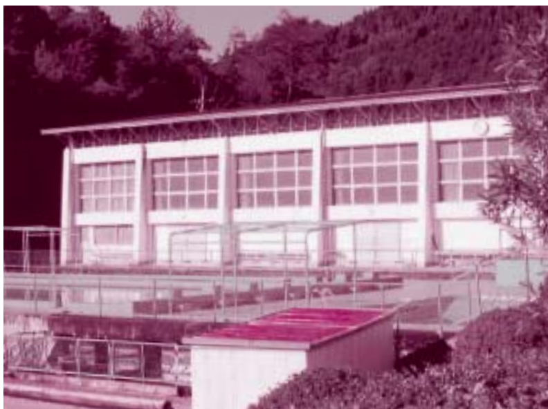
会見小学校体育館及びプール
