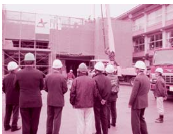
西伯小学校の改修工事
