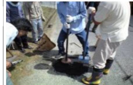
一斉清掃の後、道路に穴のあいた13箇所を補修しました(事業部)
