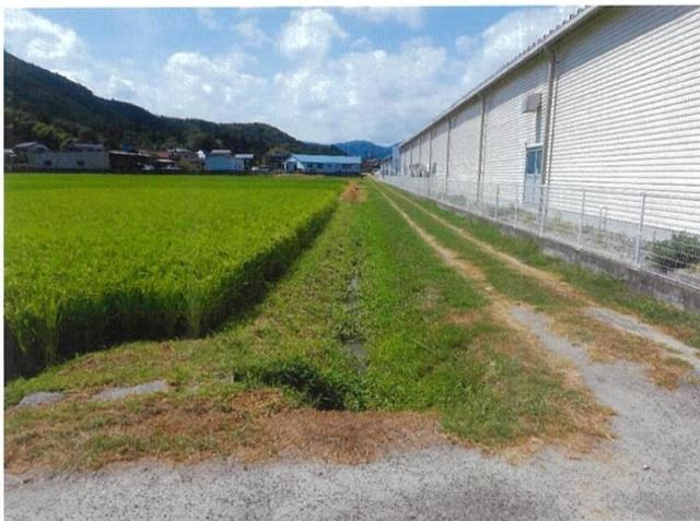
素掘り水路のため、豪雨等が原因で土砂堆積による水路機能の低下が度々生じている。
