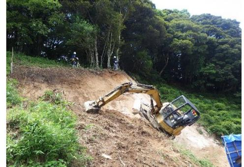
ワイヤーを使用して重機で法面を掘削する工法
