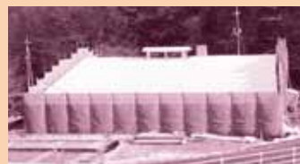
現在、建設中の拠点施設
