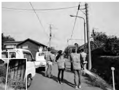
↑この道路灯、腐食して倒れそう...
