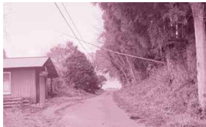
危険木の現状
