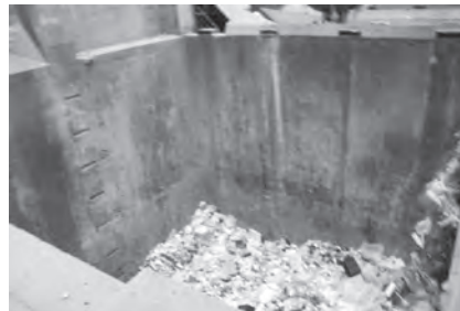
搬入されたごみは、ごみピットに集められます。不燃ごみピットの深さは9m。
