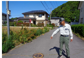
遠藤区長の説明 地下式の消火栓
