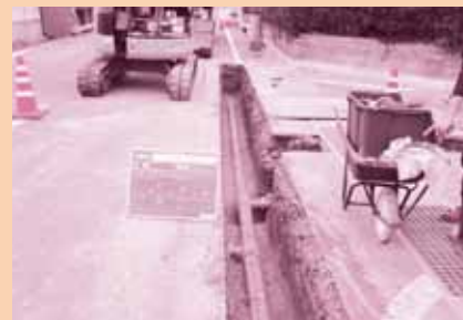
円山水道管敷設換
