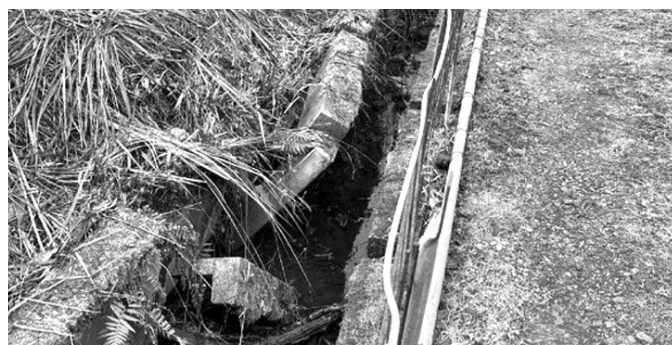
道河内地区 排水路復旧
