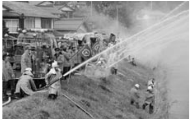
一斉放水の様子
