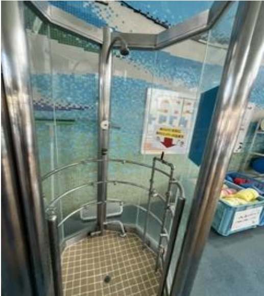
⑥プールサイドシャワー配管替工事
