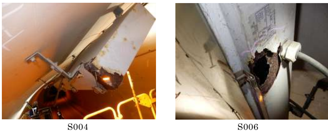
写真 4.4 孔食が確認されたトンネル照明
