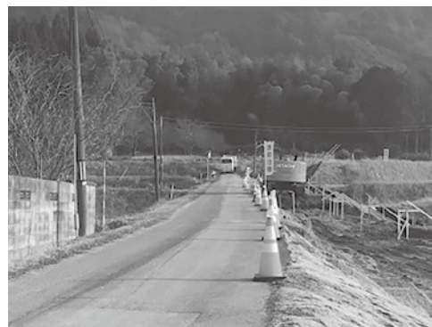
保育園入口道路工事
