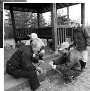
修繕作業の様子
