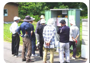
防災庫内の確認を全区で実施
