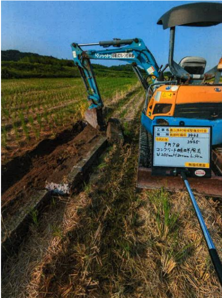
コンクリート畦畔撤去
