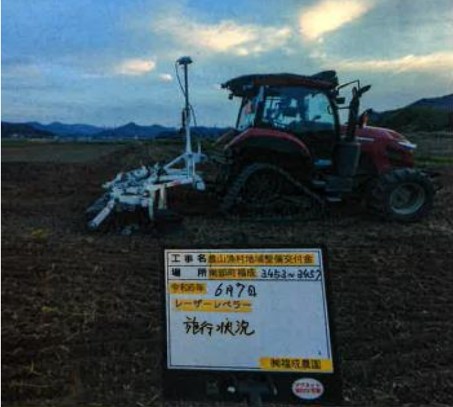
均平化(レーザーレベラー)
