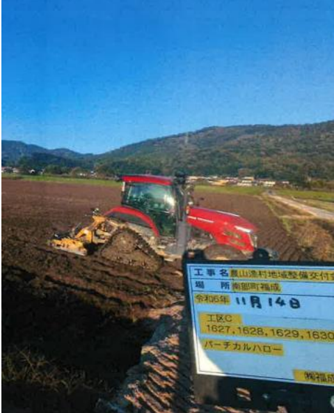
砕土、整地(バーチカルハロー)
