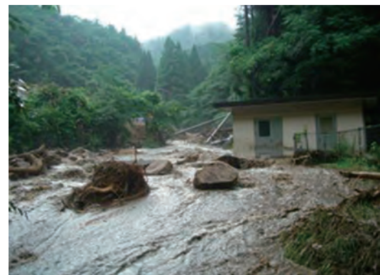
南部町で発生した災害の様子(赤谷地内)
