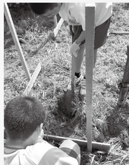
③ スコップで基礎工事
