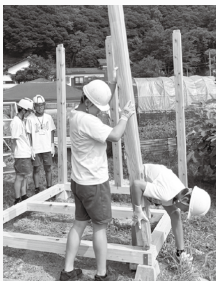
④ 柱を立てる
