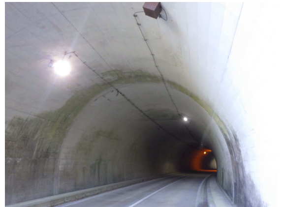
写真 4.5 トンネル照明更新状況（左：撤去箇所、右：LED 交換箇所）
