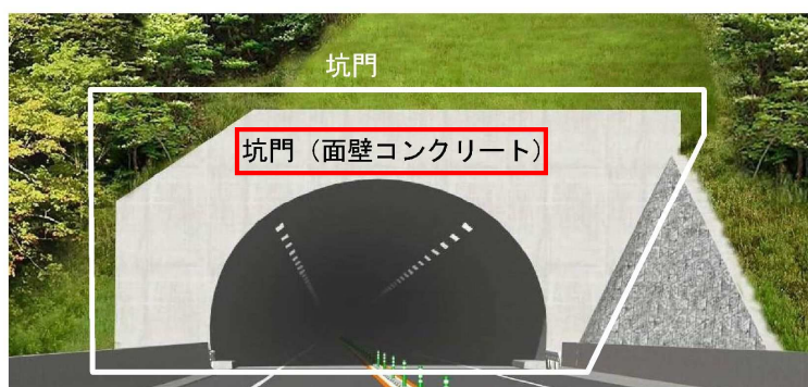
図3.1 トンネル本体工点検箇所
