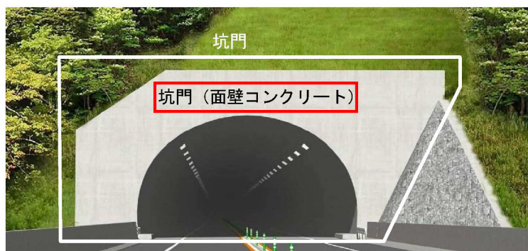
図3.1 トンネル本体工点検箇所
