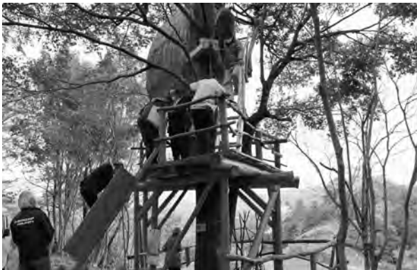
◀完成したツリーハウス
