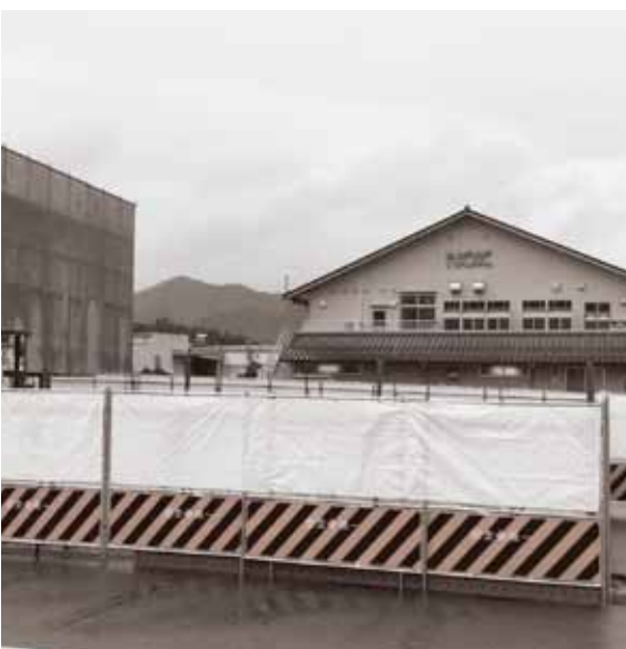
NOK(株)組立て工場の建設
