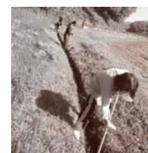
多面的機能直接支払 (合同水路掃除)
