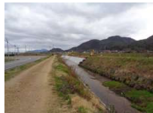
河川拡幅工事中
