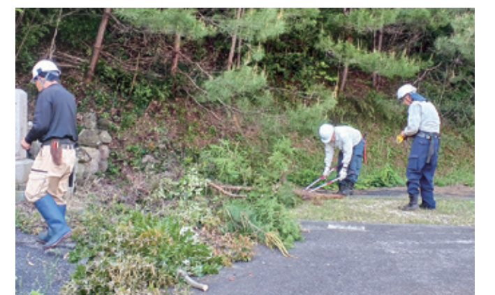
樹木伐採 チェーンソーやノコギリを使用し、1本の木を根元から切る作業です。倒した木もチェーンソーで細断し運びます。
