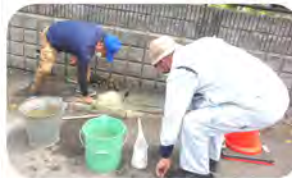
区長・班長で側溝補修
